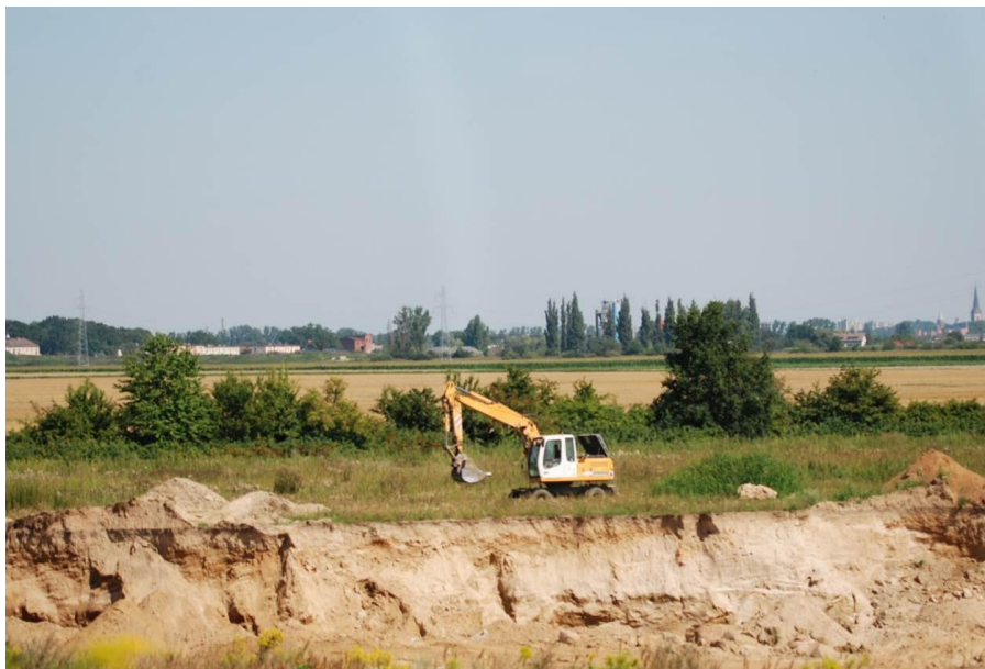
Fot. Widok na teren opracowania
