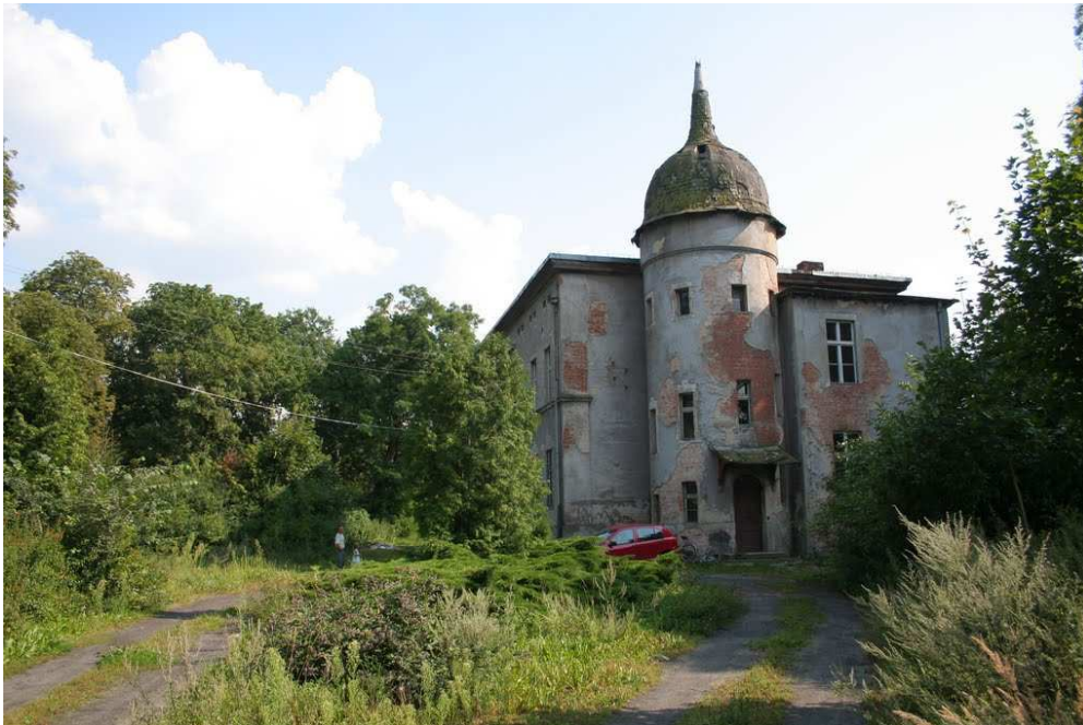
Zdjęcie 6 Pałac – elewacja frontowa.
