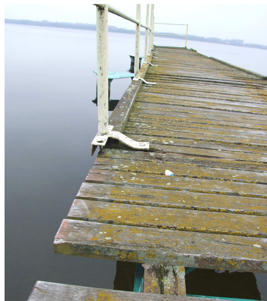
Fot.6 Mocowanie słupków balustrady do elementów drewnianych pokładu pomostu
