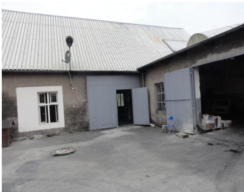
Widok na teren planowanej inwestycji.
