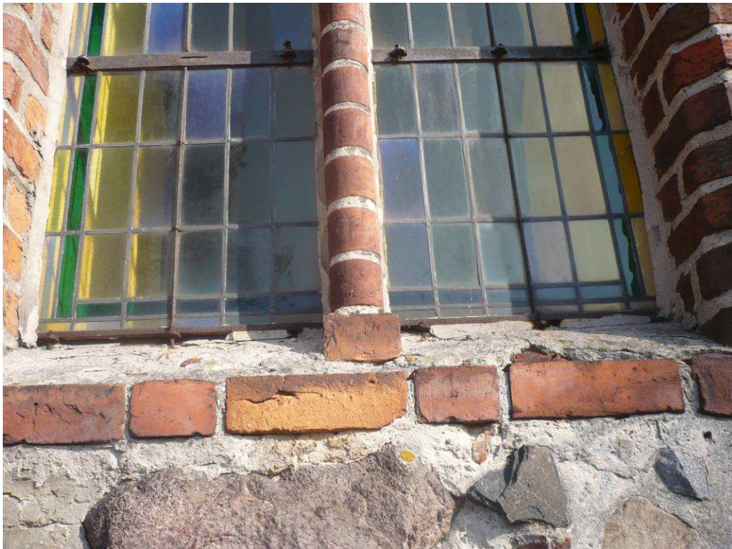
Fot. nr 5: Zdjęcie przedstawia witraż Kościoła, który wymaga wymiany ze względu na liczne pęknięcia i wykruszone spiny przytrzymujące okno.
