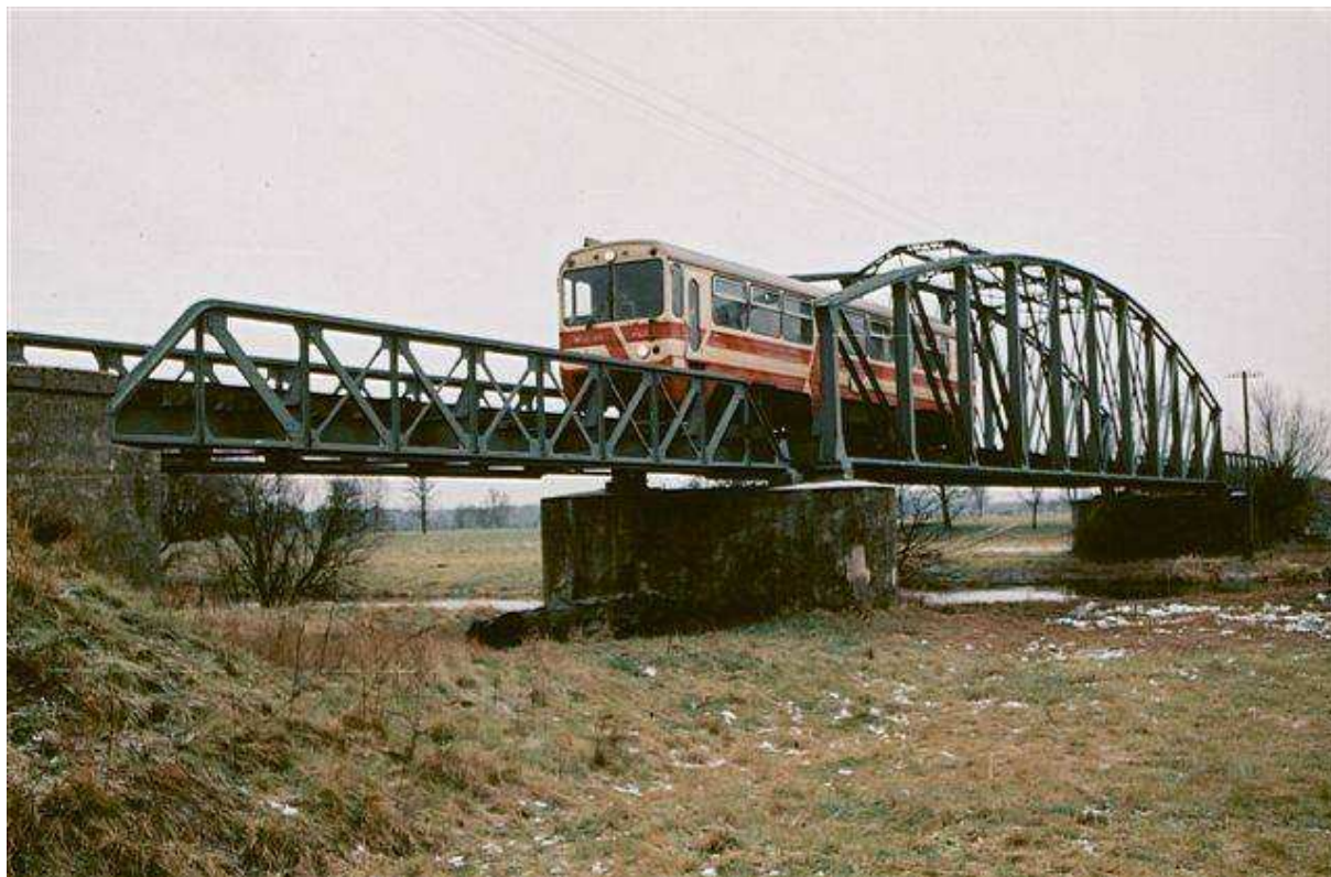
Most kratownicowy kolei wąskotorowej na Inie
