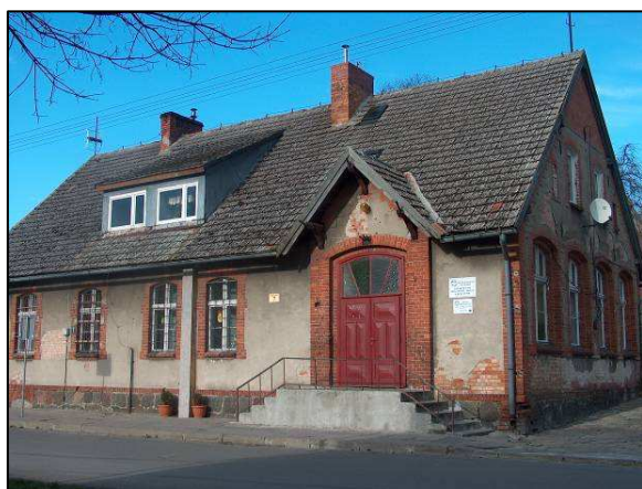
Fot. Aktualny stan świetlicy wiejskiej
